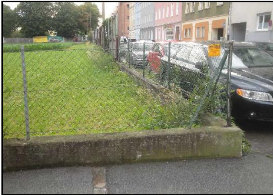
Abb. 3: Sockelmauerwerk in Stahlbeton inkl. Maschendrahtzaun im Übergangsbereich von der [REDACTED] zum projektierten Zufahrtsweg auf Grundstück [REDACTED]
